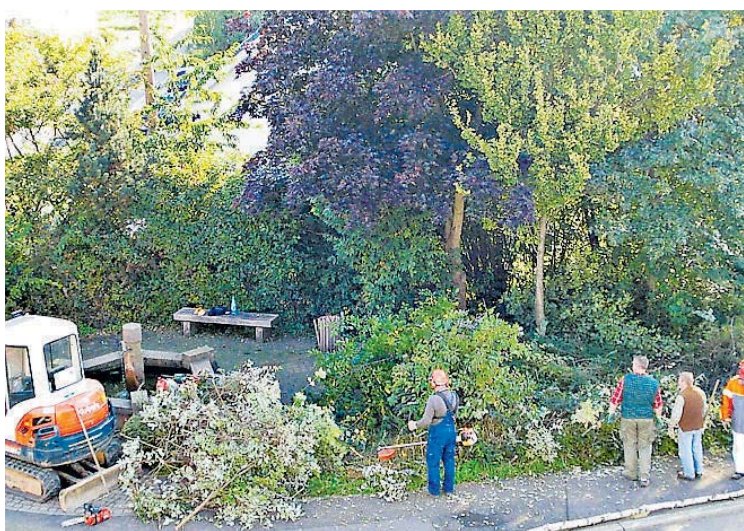
Die Helfer der Dorfgemeinschaft bereiten die Baustelle für den neuen Pavillon vor. Fotos: SZ/Verein
