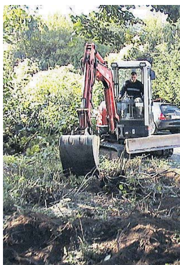
Der Bagger legt los. Kirschhof wird verschönert.
